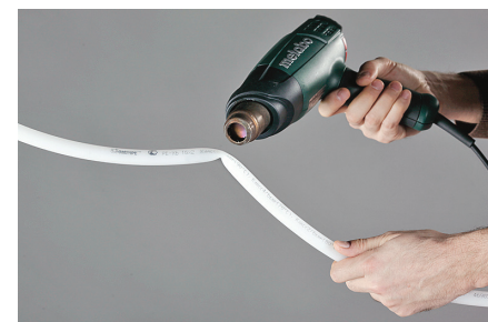
Равномерно нагреваем надломленный участок трубы монтажным феном.
