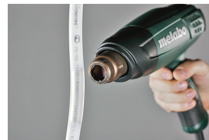
Нагреваем, пока труба не станет прозрачной.
